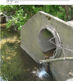
STEP-POOL STORMWATER CONVEYANCE
